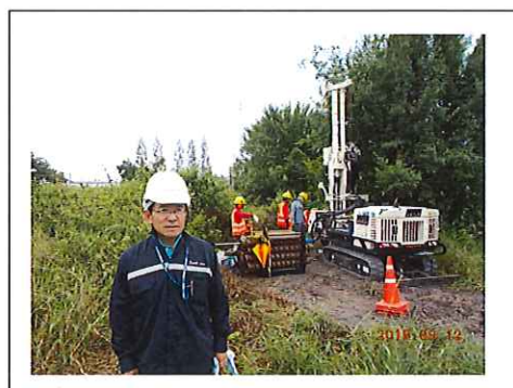
ボーリング調査状況
