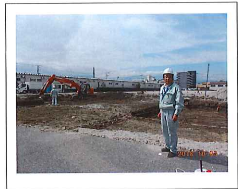
掘削搬出処理現場にて
